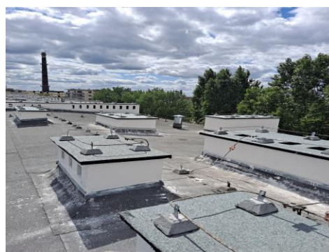
Dach Rolna 30-40 z odnowionymi kominami
