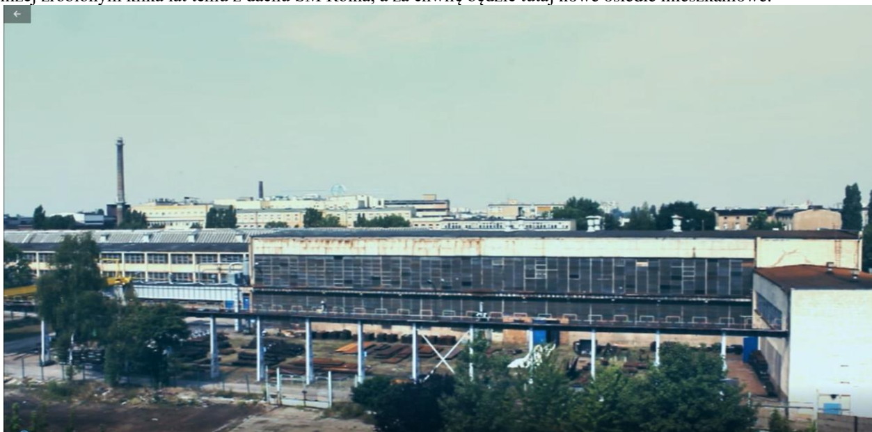
Fabryka W-9 (której już nie ma), w roku 2015
